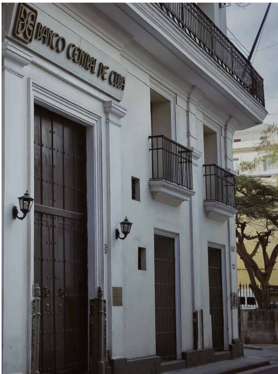
Banco Central de Cuba Calle Cuba No. 402, esquina a Lamparilla, municipio La Habana Vieja, La Habana, Cuba.
